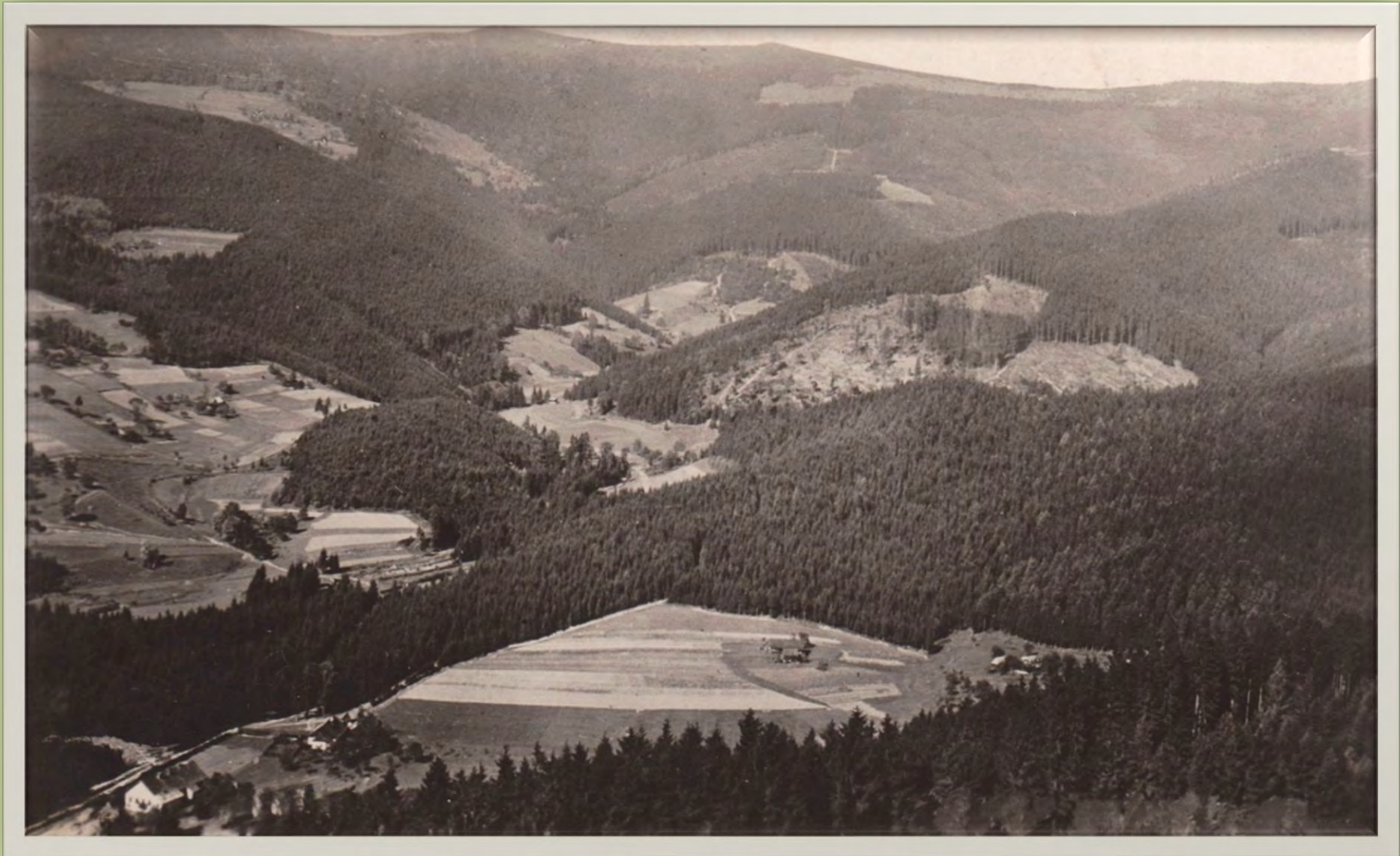
Kněhyně. Zpod Července výhled severním směrem do horní části Kněhyňského údolí se zaniklým starým názvem V Ráztokách (uprostřed snímku). Za částečně odlesněným hřbetem Malinové dosud nezalesněné stráně nad lokalitou V Huti, nad lesnatým táhlým úbočím Příkré vystupují svahy lokality Pod Stupňami (při horním levém okraji snímku).
